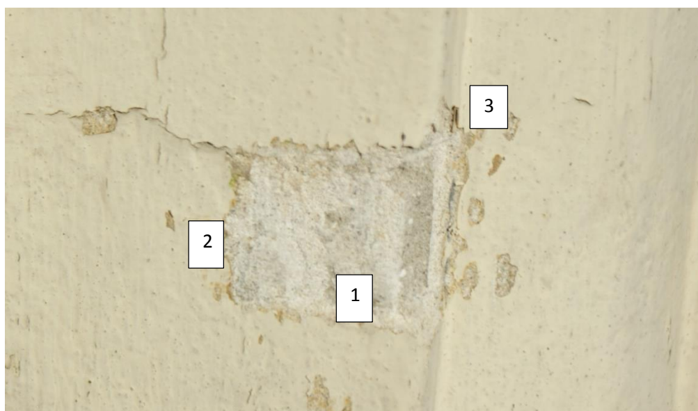
Odkrywka nr 1 – 1. – tynk podkładowy wapienny, 2. – biała warstwa malarska, 3- żółtokremowa, obecna warstwa malarska
